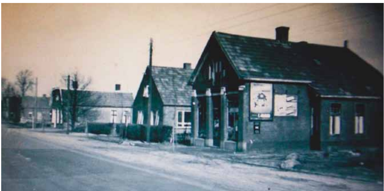
Foto uit ongeveer 1930. Het eerste huis is van de familie Heine, dan Hendriks, dan Stiene Kiers en dan Hinnek Hölscher (bron; mw Kocks-Heine).
